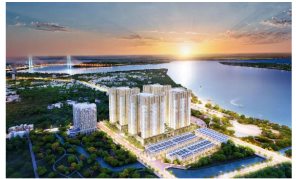
Phối cảnh dự án Q7 Saigon Riverside dự kiến bàn giao ngay trong quý III/2022 (Nguồn: BCTN HTN, CTS tổng hợp)
